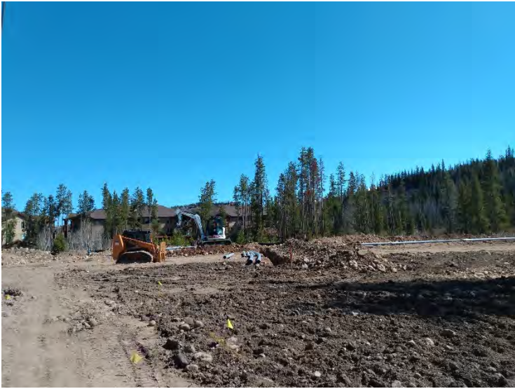
Dry Utility Conduit
